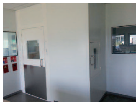
Le sas de passage des prélèvements a également été concerné par la rénovation, avec pose de joints gonflants et dispositif de désinfection approprié.
