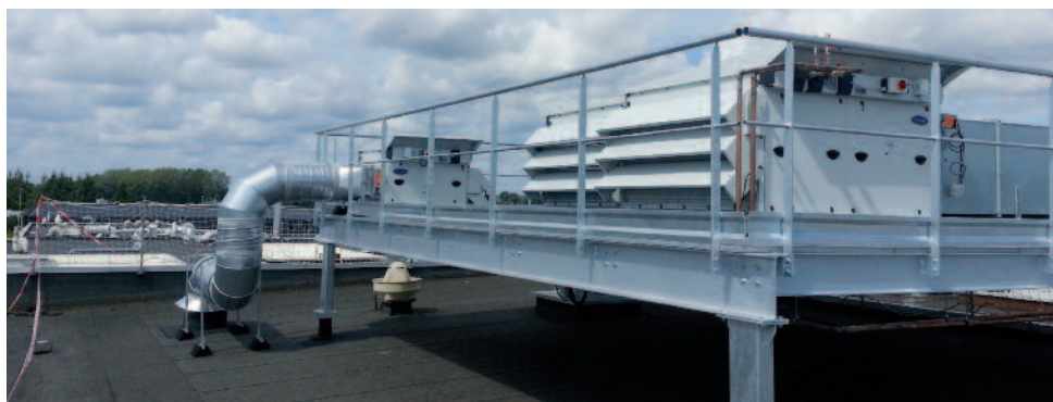
La rénovation de l'unité P3 du site de Ploufragan a porté sur ses centrales d'air, avec un système d'extraction qui a pris de la hauteur !
